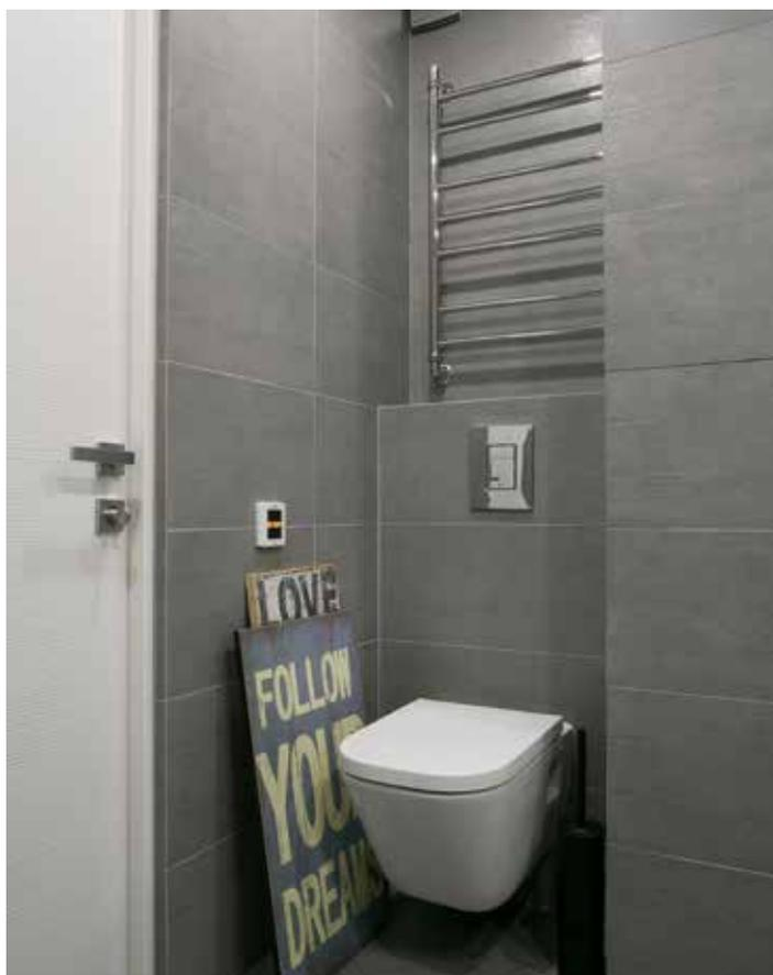
В отделке ванной комнаты использован керамогранит: на стенах он имитирует бетон, на полу — металл с насечкой.
